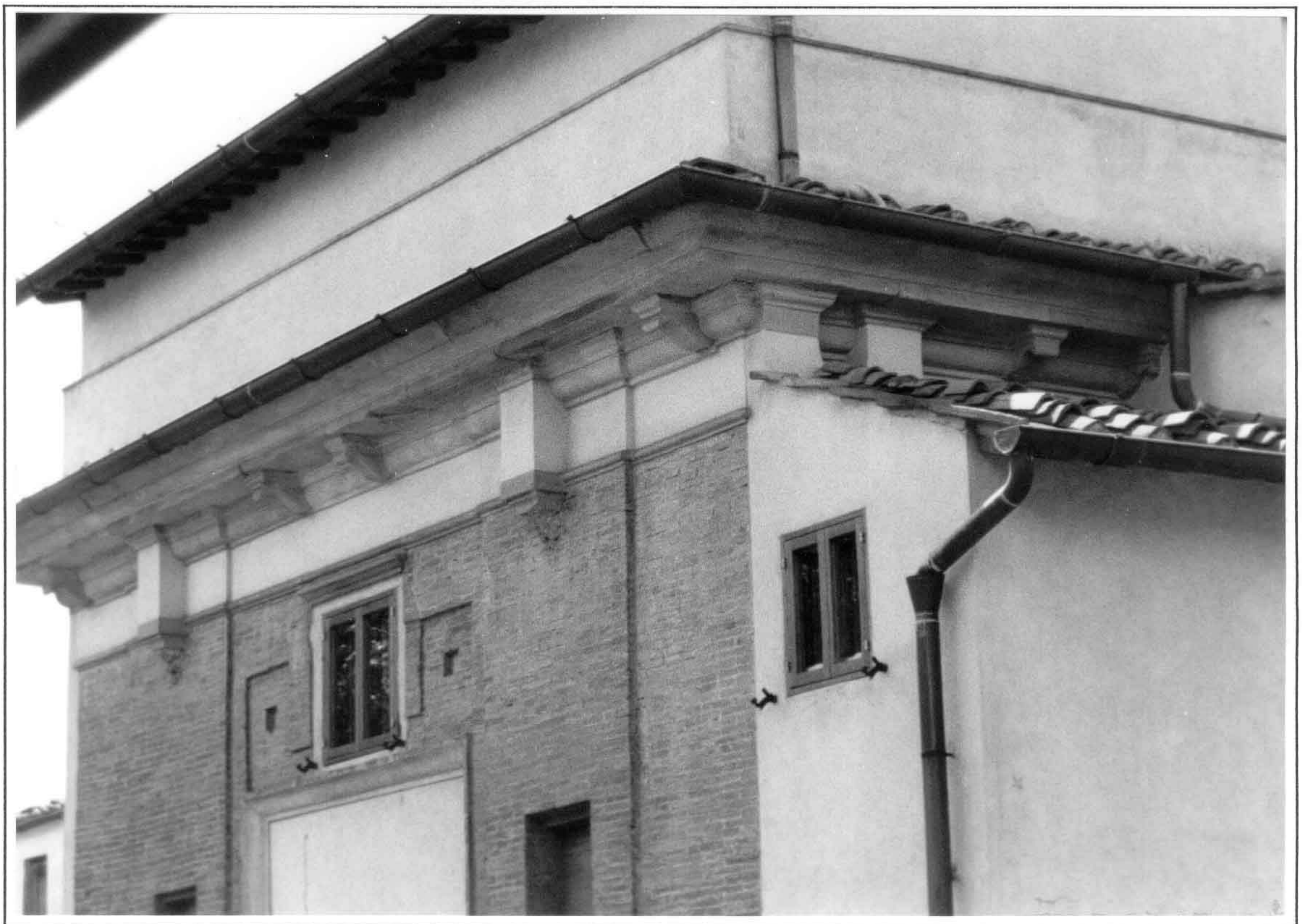
Das Traufgesims an der Westseite des Ateliergebäudes
